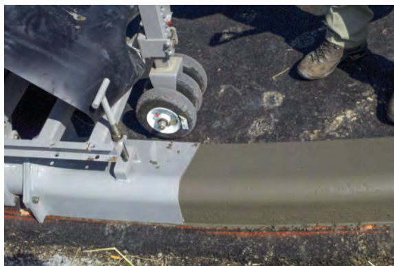
Используя разметку мелом или краской на поверхности как ориентир, оператор четко контролирует траекторию укладки перед машиной
