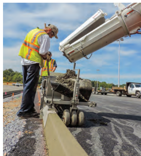
Экструдер легкий в управлении: один рабочий управляет, второй контролирует подачу бетона или асфальта к шнеку
