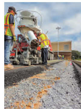
Экструдер 150 обеспечит аккуратный прямой бордюр на грунтовом основании со степенью уплотнения 95%, или по существующему покрытию
