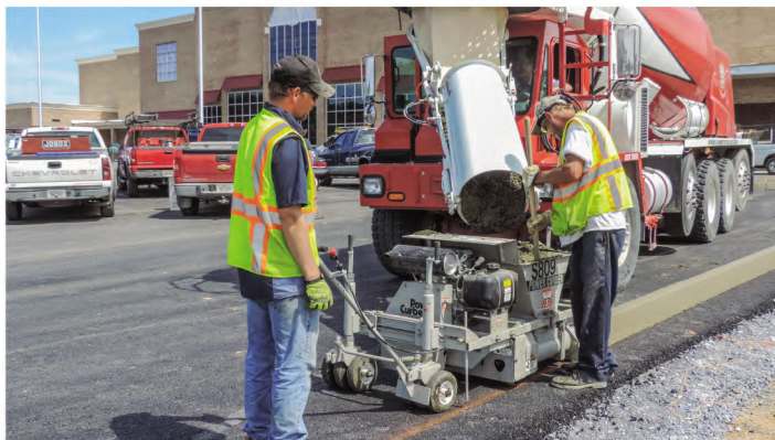
▲ Бордюроукладчик-экструдер "Power Curbers" 150
