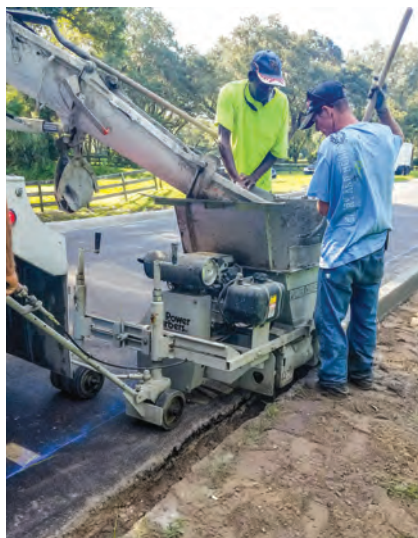
Передние колеса у 150 могут быть смещены в сторону при укладке поверх траншеи
