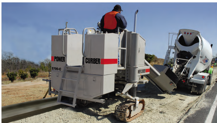
▲ Бетоноукладчик со скользящими формами 5700-C
