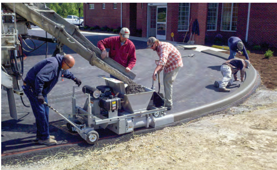
Процесс выдавливания толкает машину вперед
