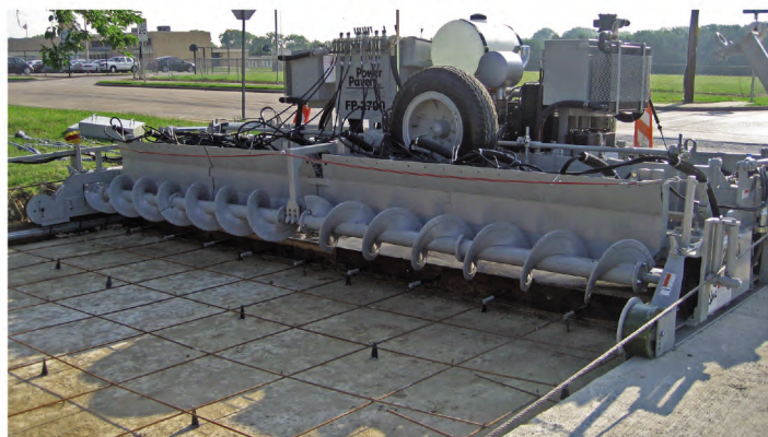
▲ Рельсовые бетоноукладчики Power Pavers FP-2700 и FP-3000
